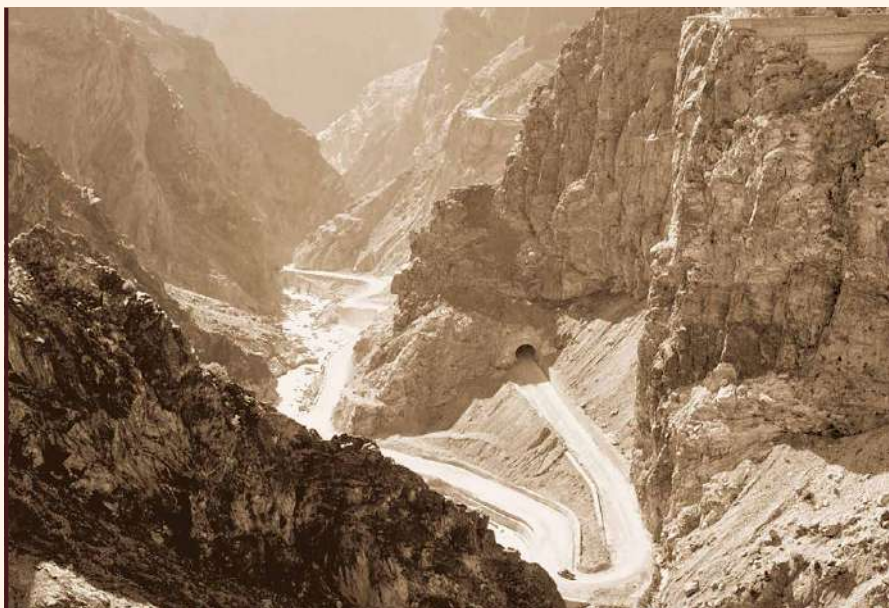
Дорога Кабул-Джелалабад в сторону Нангархара проходит через многометровые тоннели и галереи перевала Махипар. Афганистан, 1984 г.
